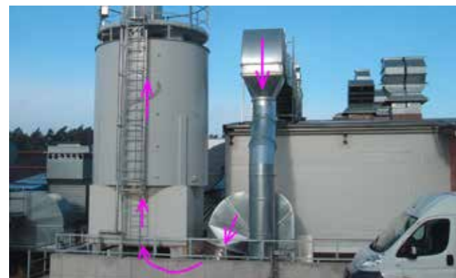
Abb. 1: Zufuhr des lösemittelhaltigen Abgases in den mit Lavagestein gefüllten Biorieselbettreaktor
