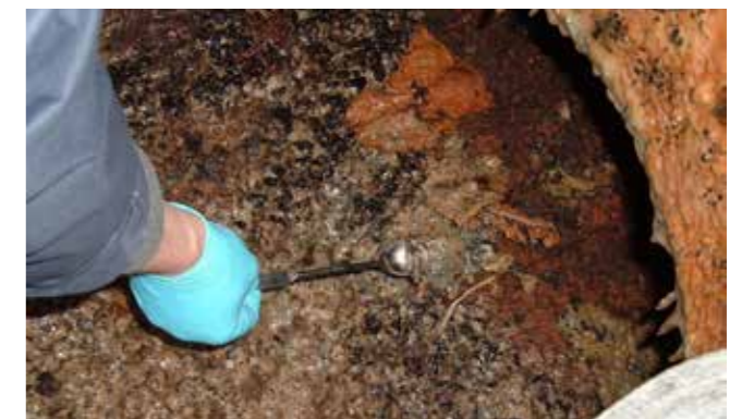
Abb. 6: Blick in die, mit einem Biofilm bewachsene Oberfläche der Lavagesteinschüttung im Biorieselbettreaktors
