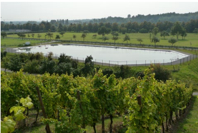
Abb. 2: Speicherbecken unterhalb des Weinbergs
