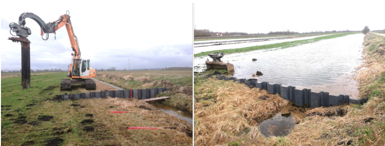
Abbildung 6 Einbau der Grabenverschlüsse aus Kunststoffspundwänden am Versuchsstandort RH.
