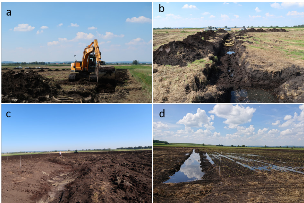
Abbildung 10 a und b) Durchtrennung bzw. Entfernen der ehemaligen Drainagerohre im Bereich der gesamten Versuchsfläche. c) Angelegter, mäandrierender Graben zur Einleitung des Bewässerungswassers. d) Wassergefüllter Querverteiler oberhalb der gepflanzten Typha angustifolia Versuchsfläche unmittelbar nach der Wassereinleitung.
