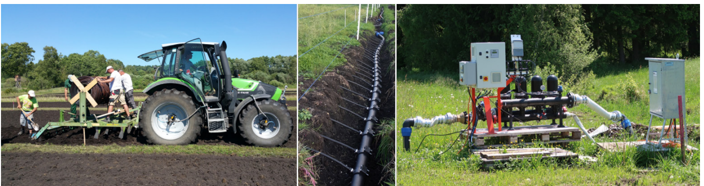
Abbildung 3 Einbau der Unterflurbewässerung am Versuchsstandort Freisinger Moos. Linkes Bild: Mittels umgebauten Grubber werden die Tropfschläuche in 20 cm Bodentiefe abgelegt. Bild Mitte: Alle 40 cm sind die Tropfschläuche mit einem Quer Rohr verbunden. Rechtes Bild: Provisorisch aufgestellte, selbstreinigende Filteranlage sowie Modul zur Steuerung der Unterflurbewässerung.
